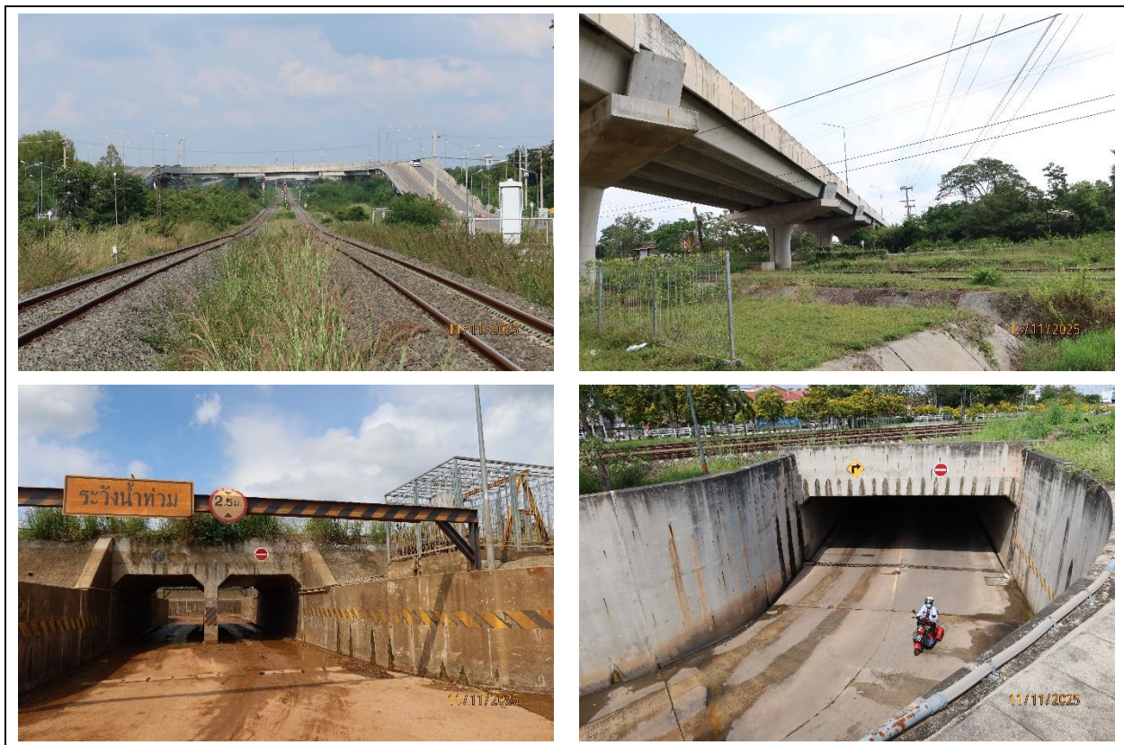
รูปที่ 3.2-1 ทางข้าม / ทางลอด เพื่อใช้เป็นเส้นทางสัญจรข้ามระหว่างทางรถไฟ
